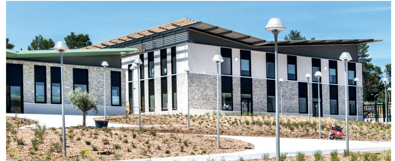
Centre pénitentiaire de Draguignan
